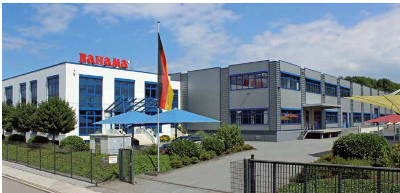
Usine BAHAMA à Reichshof-Wehnraath (près de Cologne) – Superficie totale avec exposition permanente extérieure : 26.000 m 2 .
