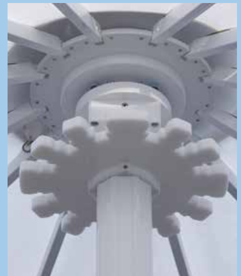
«Couronne» avec quadruple dispositif anti-torsion dissimulé ; dessous : couronne de positionnement pour fermeture et transport
